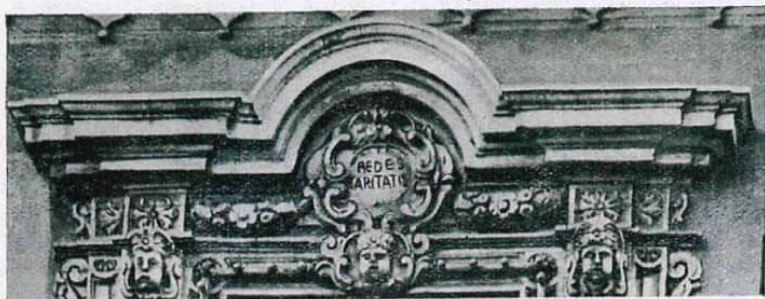
Fig. 7 — Particolare del Palazzo Tezzano
